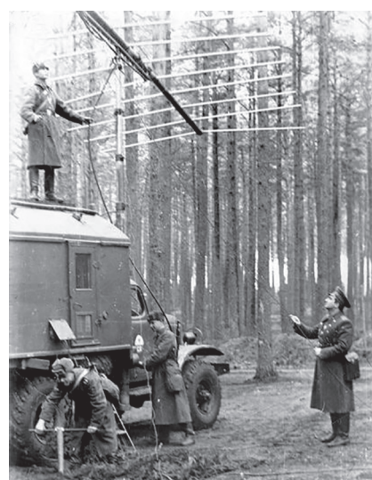
Тропосферная радиорелейная станция Р-122 (шифр «Лодка»)
