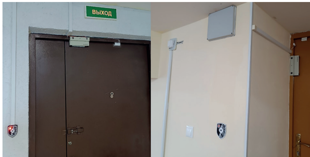
Рис. 2. Практическая реализация распределённой IoT-подсистемы контроля безопасности: слева – вариант установки в роте; справа – вариант установки в технопарке
