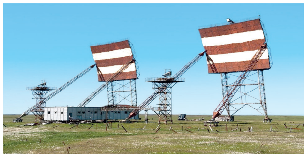
Рис. 8. Тропосферная станция TP-120
